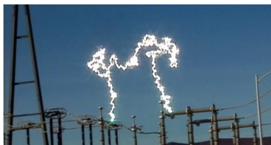
Figura 3.10: Exemplo de um Arco Elétrico [26]
